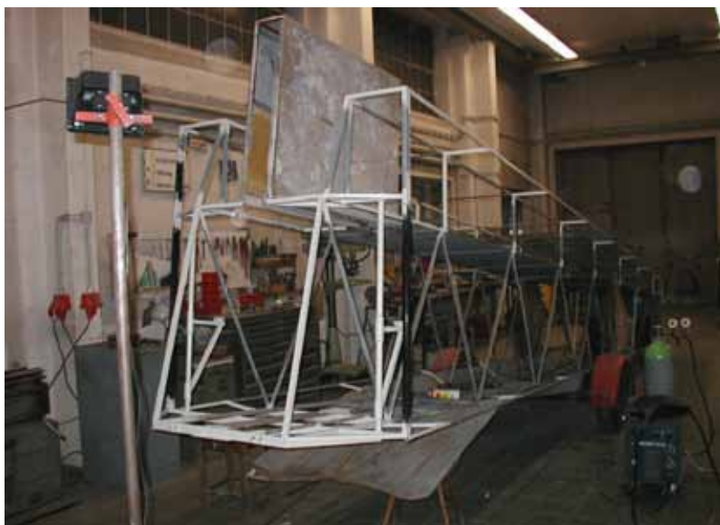
Der Rohbau des Hängers fast fertig
