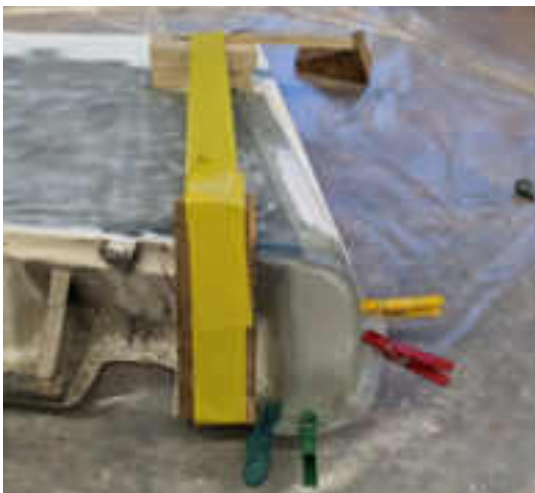
Reparatur des Schadens am Seitenruder
